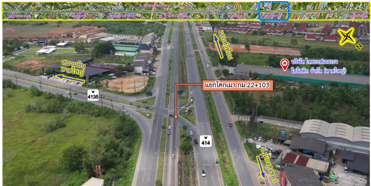
รูปที่ 5-4 สภาพปัจจุบันของแยกโคกเมา กม.ที่ 22+103
