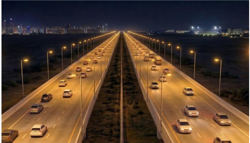
รูปที่ 7.6-2 ระบบไฟฟ้าบนสะพานข้ามทางแยก
