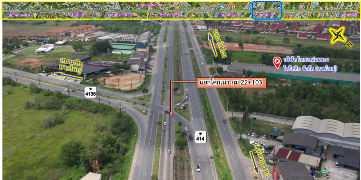
รูปที่ 5.3-1 สภาพปัจจุบันของแยกโคกเมา กม.ที่ 22+103
